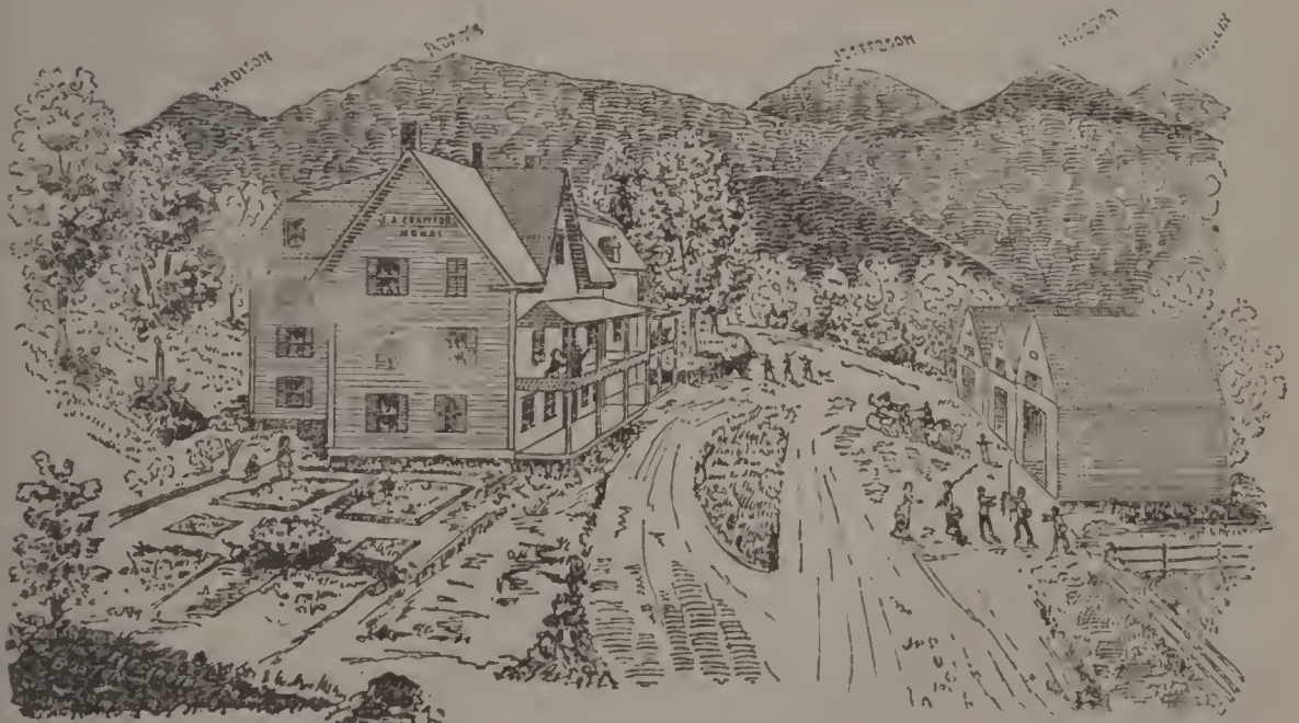
E. A. CRAWFORD HOUSE, JEFFERSON, N. H.
